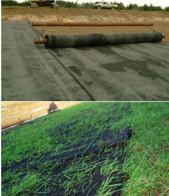
Рис.3. Влаштування EnkaMat A20 на схилі берега
