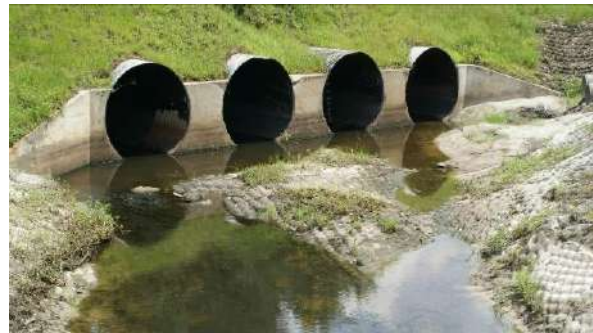
Рис.2. Захисту нижнього б'єфу водопропускних споруд матрацами
